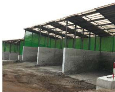
ストックヤード 混練物を所定の強度が出るまで養生します。その後、ブレーカーにて荒割破壊します。
